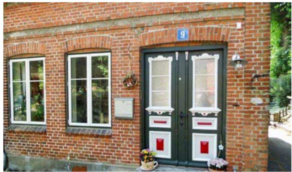
Qualitätsarbeit von JP Bauelemente: Dänische Holzfenster mit zierlichen Profilen und eine sanierte Original-Haustür aus dem 19. Jahrhundert. Die Haustür erhielt eine neue Isolierverglasung, eine neue Schwelle und neue Dichtungen.
