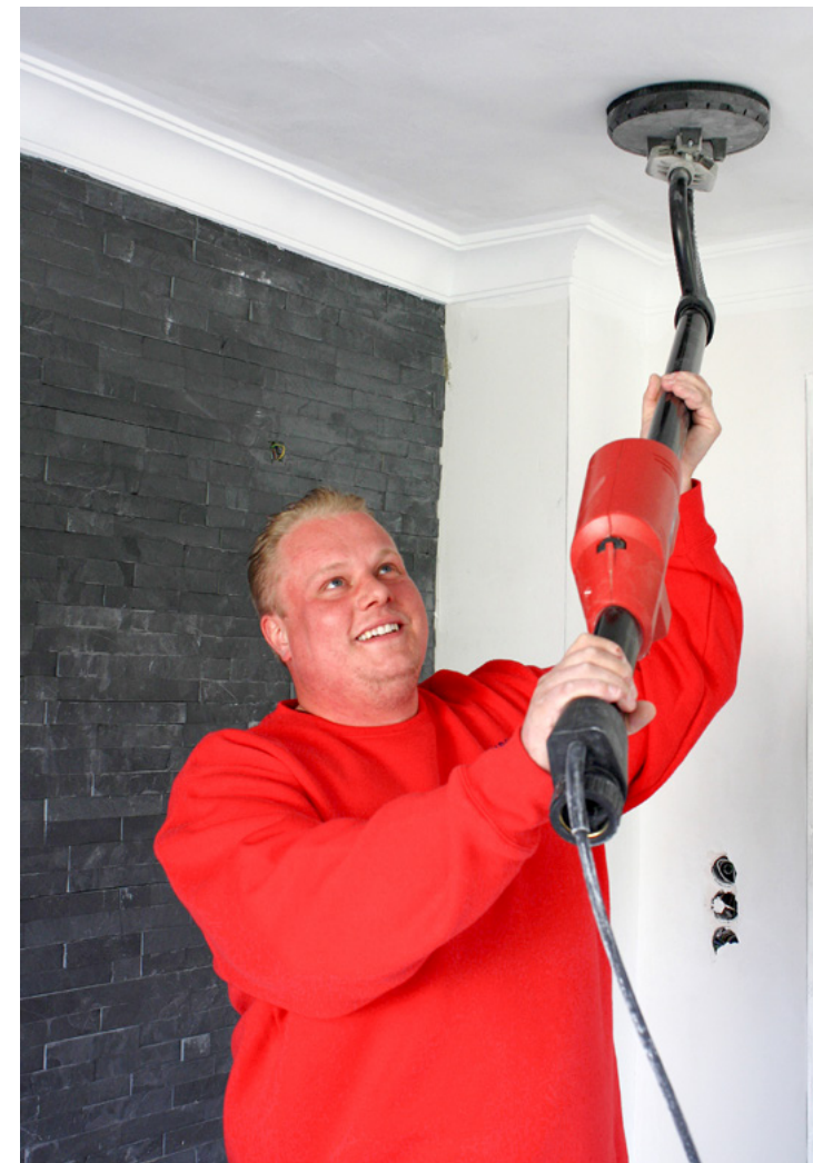
Vor dem Streichen wird die Decke abgeschliffen
