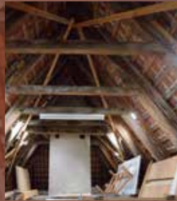
...durch die das Dach im 18. Jahrhundert seine heutige Form einschließlich Giebel an Süd- und Nordseite erhielt...
