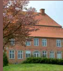
...allerdings wurde der nördliche Giebel später zurück gebaut...
